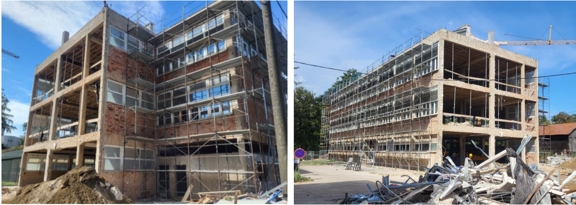
Slika 82.: Istočna fasada za vrijeme obnove [26]
