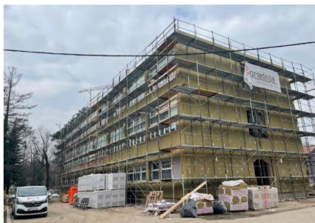
Slika 86.: Radovi obnove pri završetku [26]
