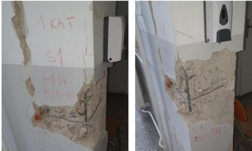
Slika 13.: Utvrđivanje količine ugrađene armature i provjera dimenzija konstruktivnih elementata [6]
