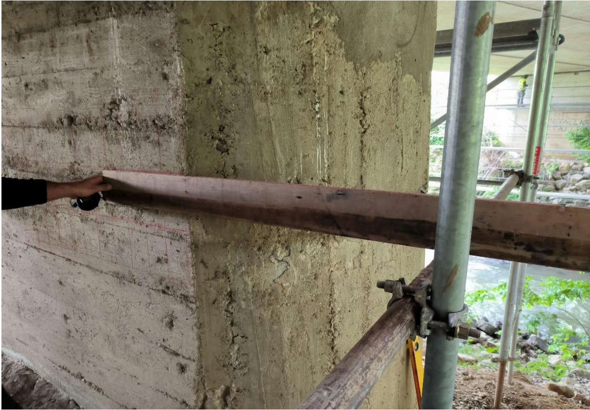
Slika 38. Prenošenje linije na susjednu ravninu
