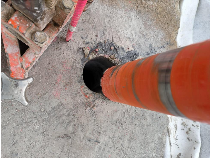
Slika 26. Bušenje uzorka betona iz konstrukcije
