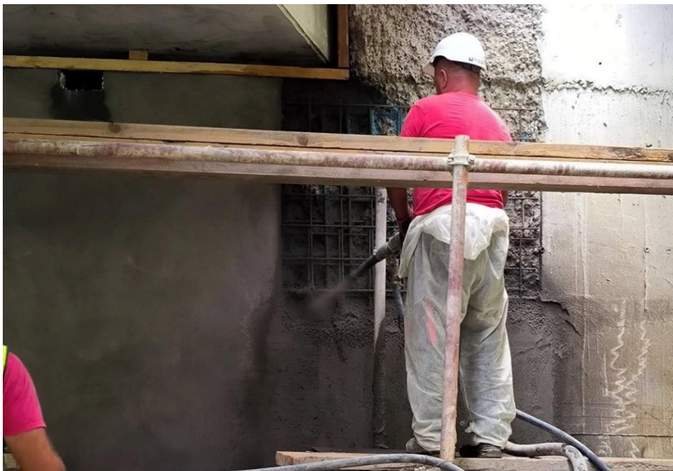
Slika 30. Strojna ugradnja morta na čeonom zidu upornjaka
