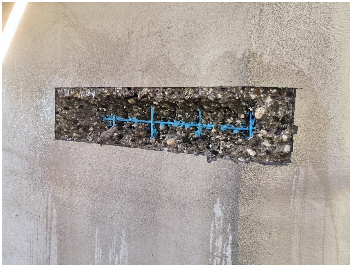
Slika 47. Zaštita postojeće armature
