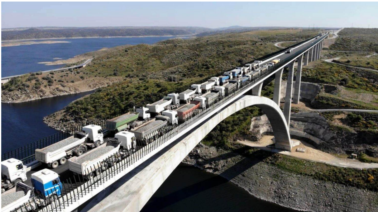
Slika 1. Prikaz probnog opterećenja na mostu [3]
