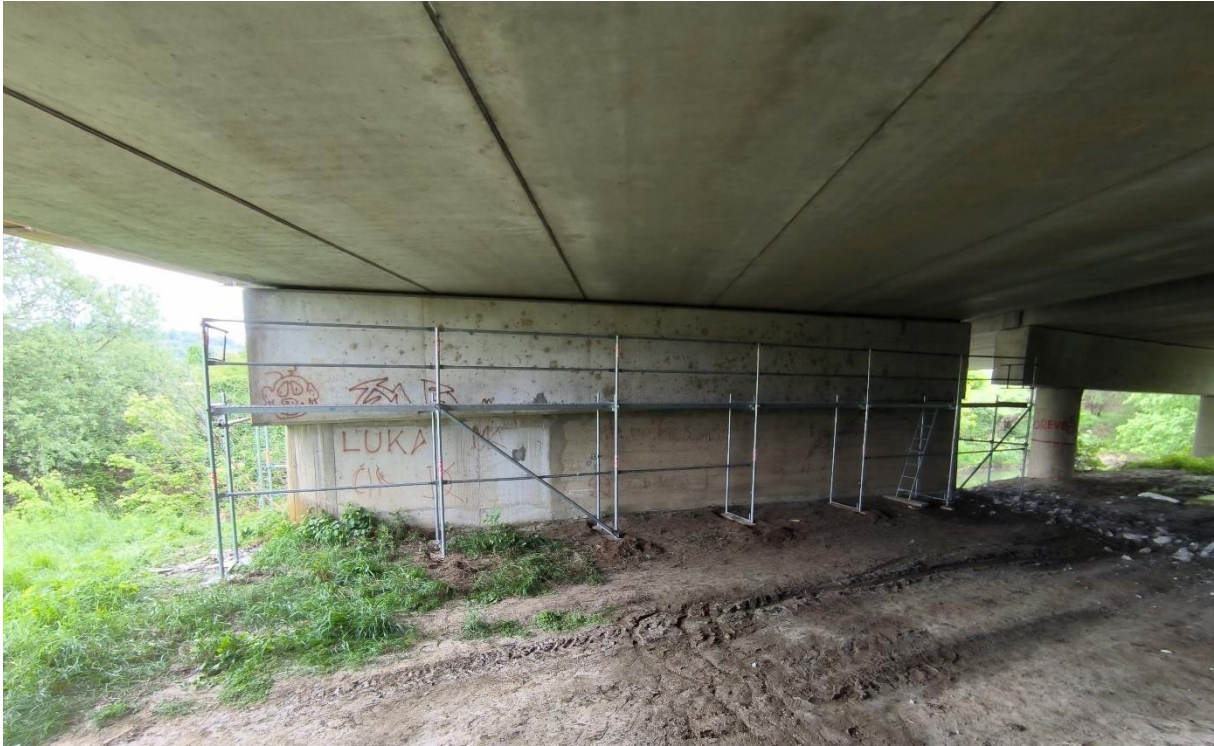
Slika 25. Pogled na stupište S1
