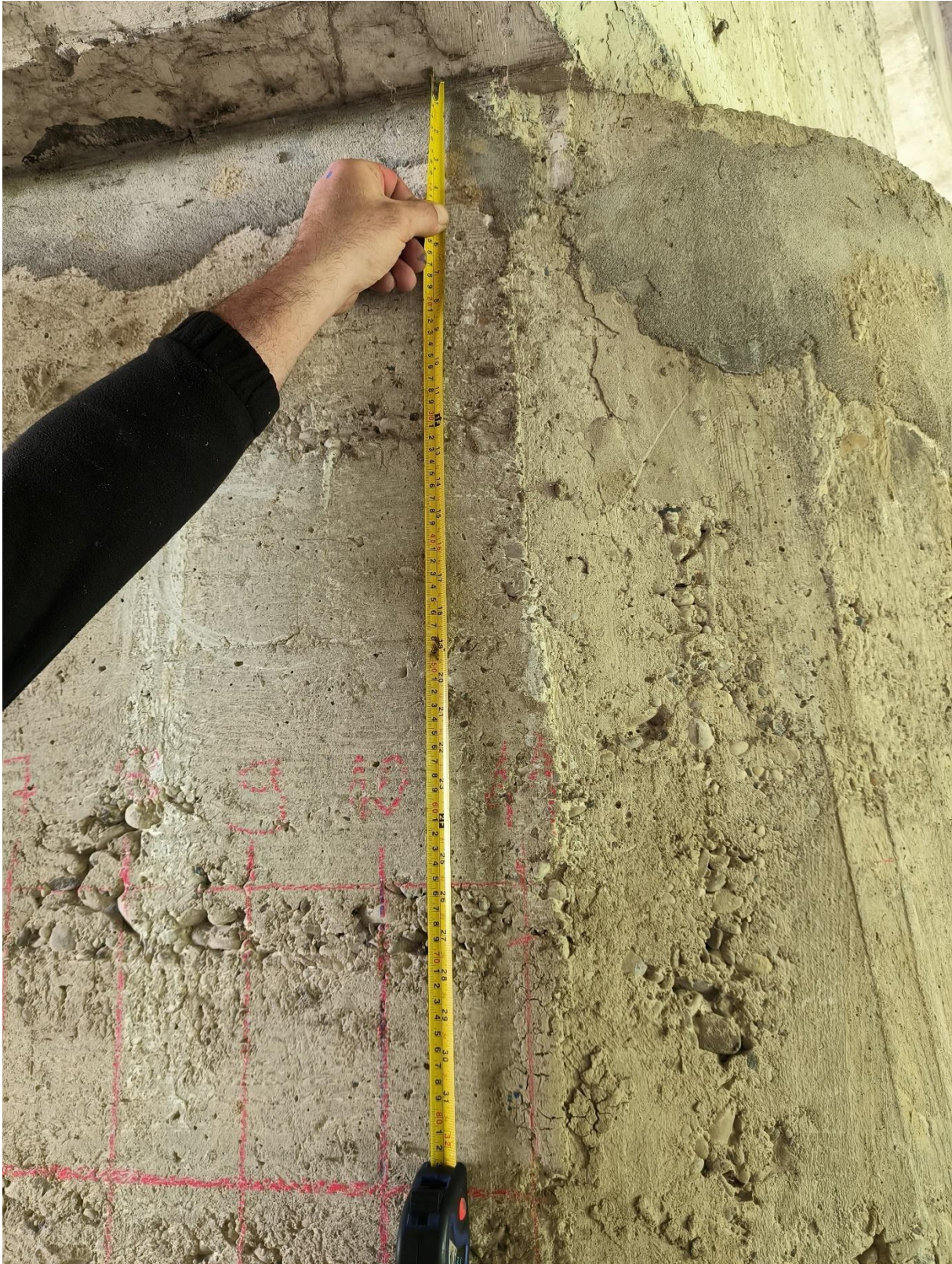
Slika 40. Odmjeravanje pozicije pomoću naglavne grede
