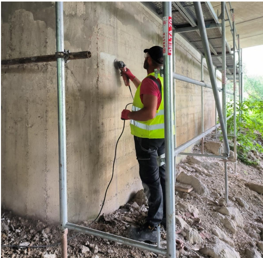
Slika 35. Brušenje postojećeg betona brusilicom za beton
