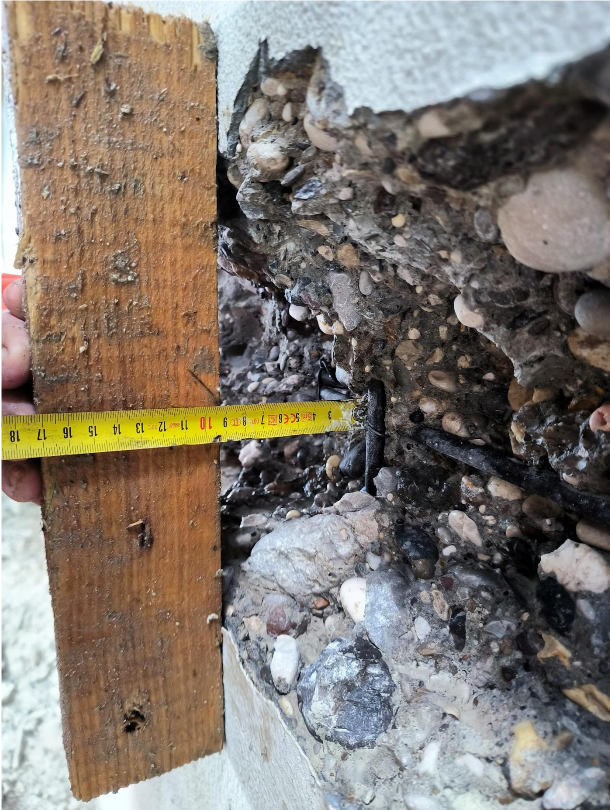
Slika 46. Mjerenje dubine uklonjenog postojećeg betona
