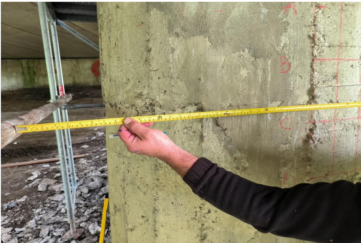
Slika 39. Prenošenje linije na susjednu ravninu pomoću mjerne trake
