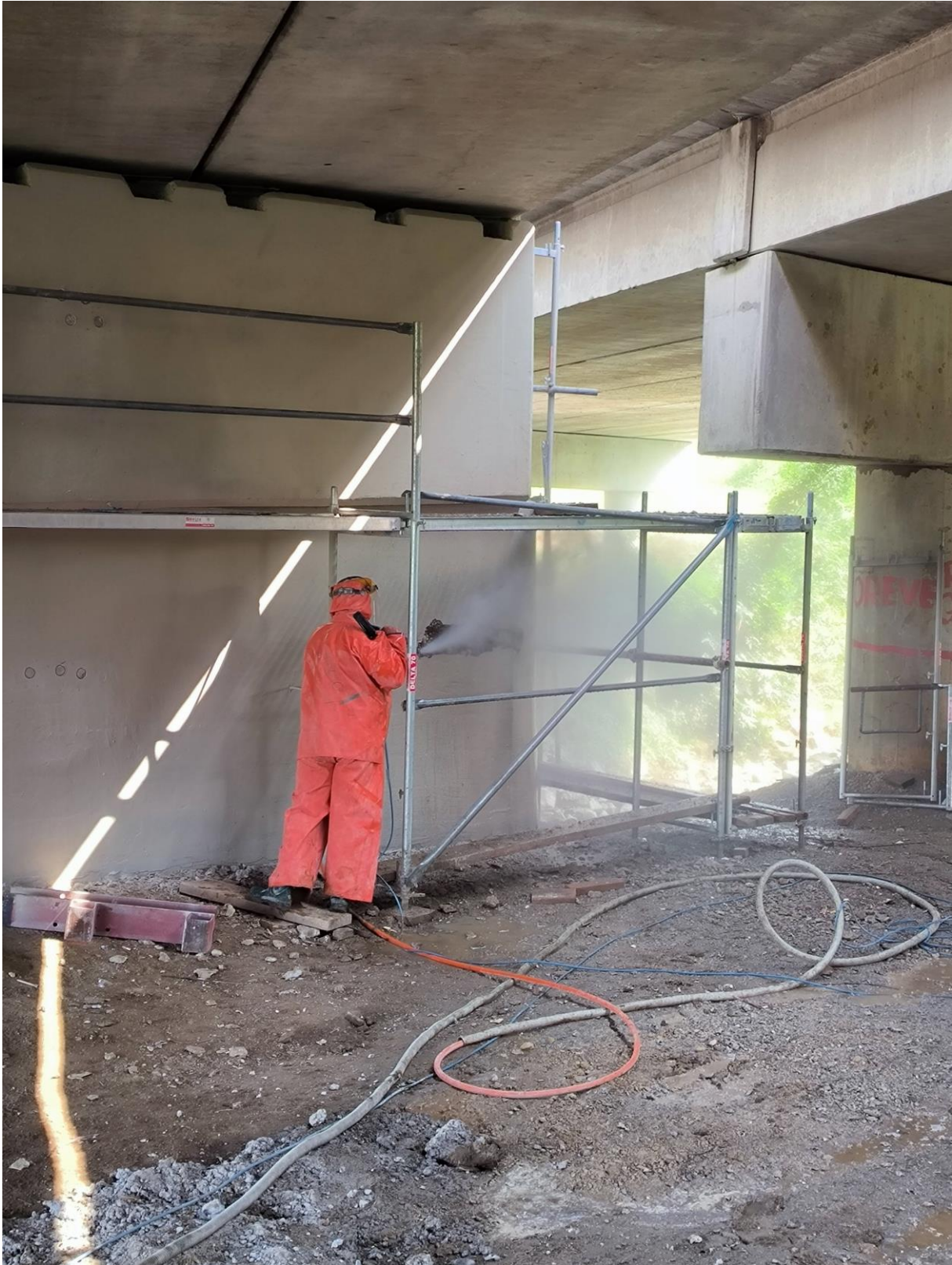
Slika 44. Hidrodinamičko uklanjanje betona stupašta S1
