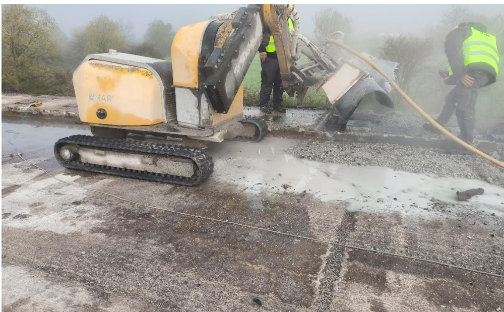
Slika 29. Robot za hidrodinamičko ukljanjanje betona
