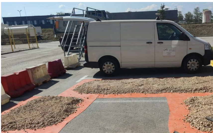
Slika 7-6 Priprema materijala za ugradnju u kalup
