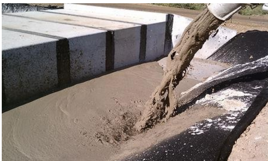
Slika 4.13. Ugradnja CSLM-a ( www.rockhillconcrete.com )
