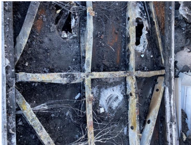
Slika 37: Horizontalni dio čeličnog nosača između čvorova 5 i 8
