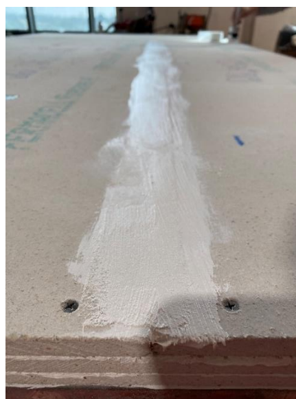
Slika 10: Intumescentni materijal za spojeve ploča
