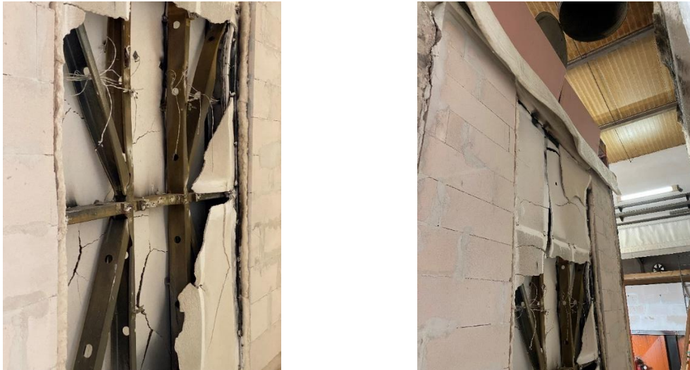
Slika 23: a) Izložena čelična konstrukcija Panela 1 nakon ispitivanja b) Gornji dio uzorka na izloženoj strani
