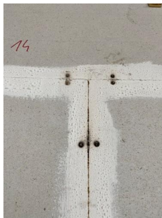
Slika 21: Detalj spoja ploča Panela 1
