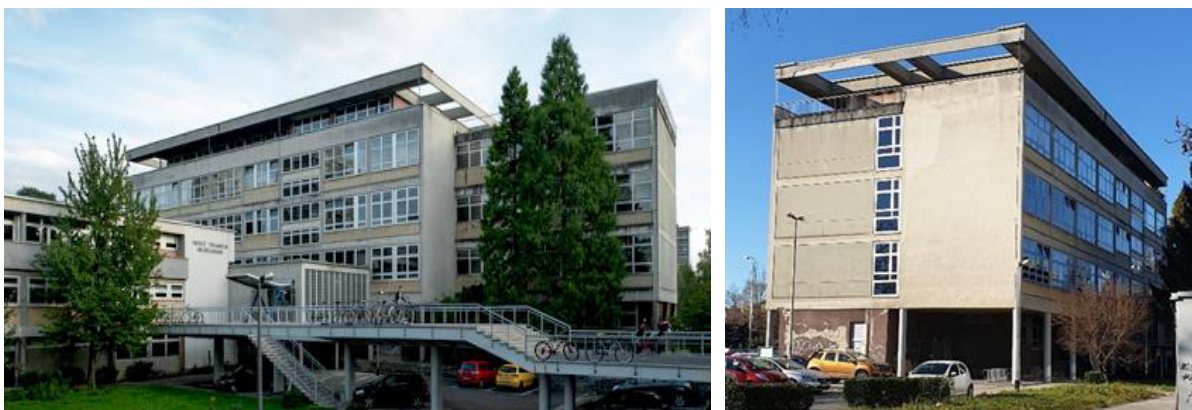
Slika 5 Pogled na dilataciju A a) sjeverno pročelje b) istočno pročelje (Izvor: a) [9], b) projekt Capital Ing d.o.o.)
