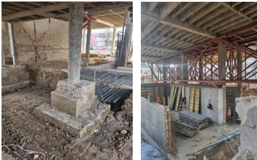
Slika 24 Prikaz konstrukcijskih detalja za vrijeme obnove građevine
