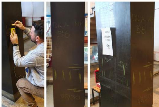
Slika 26 Utvrđivanje armature stupova nerazornom metodom (profometar) (Izvor: projekt Capital Ing d.o.o.)
