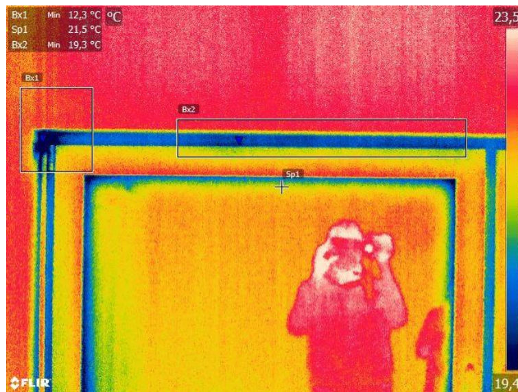
Slika 10. Termogram prozora s unutarnje strane [9]
