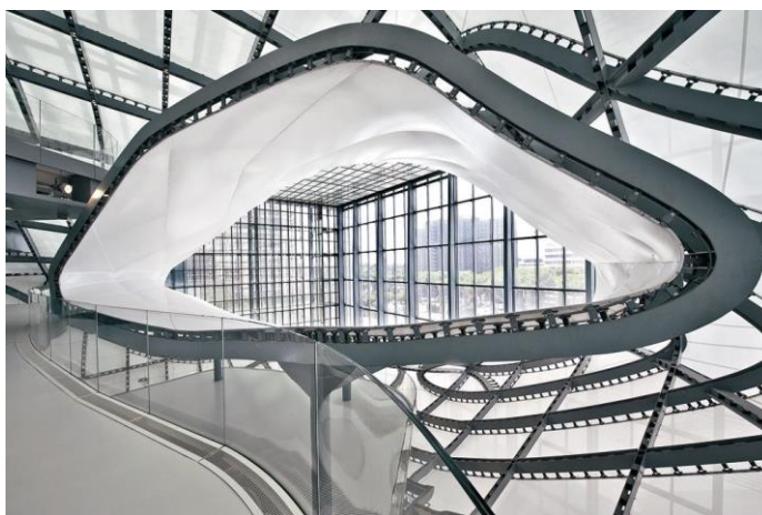
Slika 27., Unutrašnjost objekta- Vierendeelovi nosači [23]
