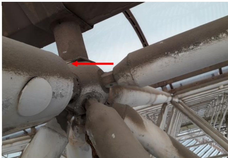
Slika 30., Detalj spoja- MERO kugla [25]
