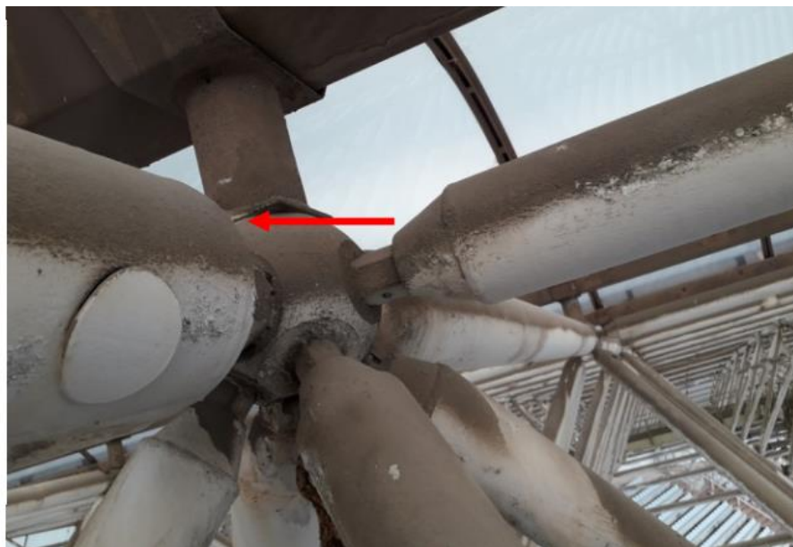
Slika 30., Detalj spoja- MERO kugla [25]
