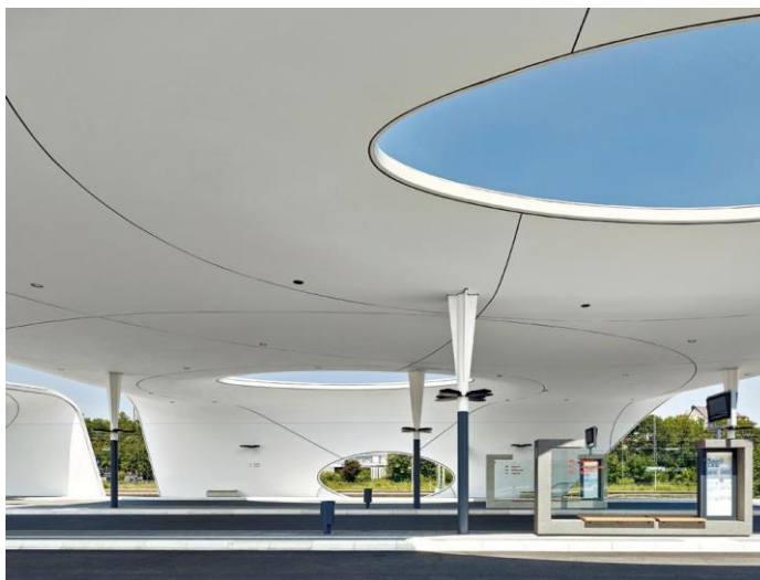
Slika 23., Stupovi i svjetla na njima [23]
