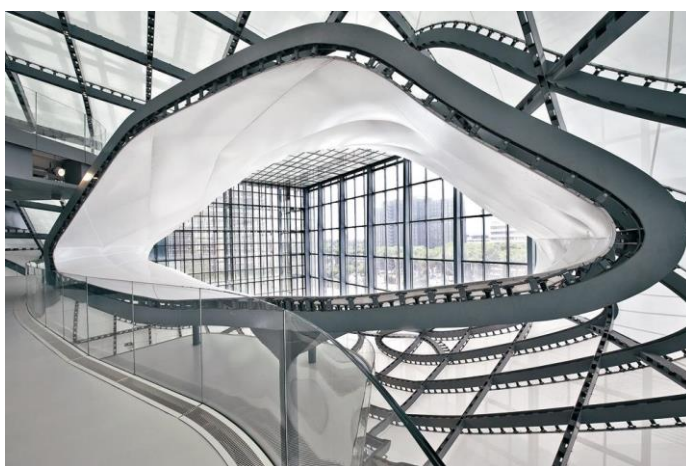
Slika 27., Unutrašnjost objekta- Vierendeelovi nosači [23]
