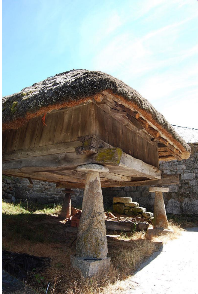
Slika 2. Temeljenje na kamenu
