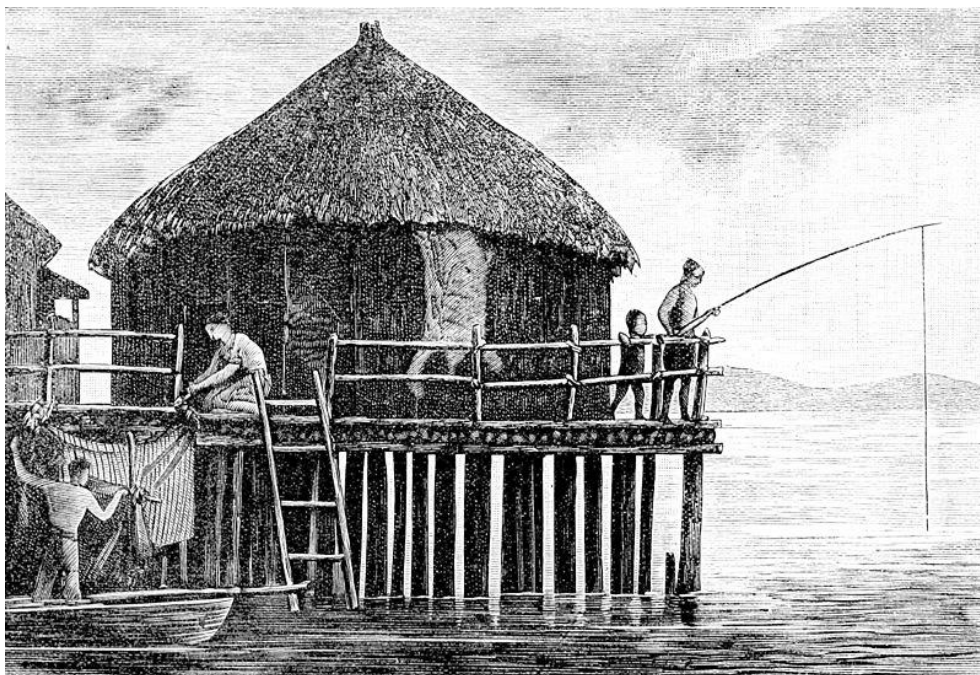
Slika 3. Temeljenje na drvenim stupovima
