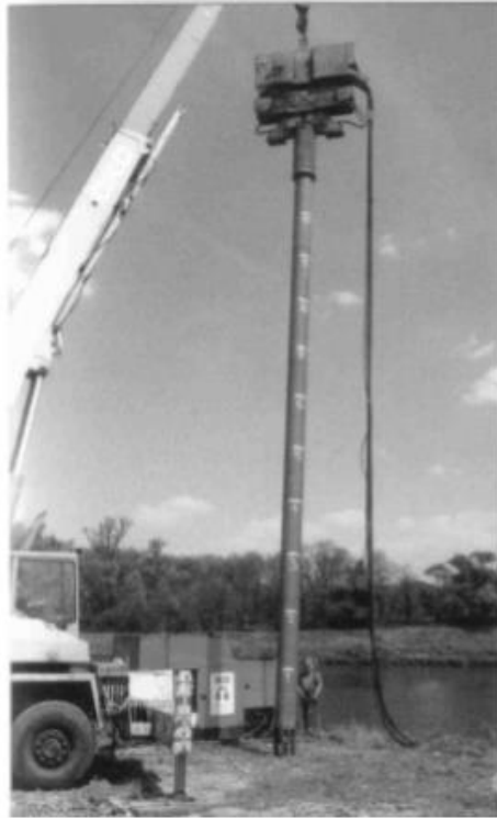
Slika 29. Zabijanje pilota pomoću vibro-glave
