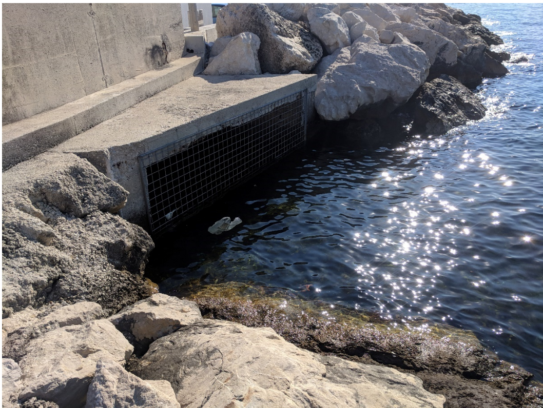
Slika 89 Propust pravokutnog poprečnog presjeka u ACI marini Split
