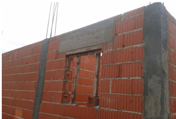
Slika 8: Konstruktivni toplinski most
