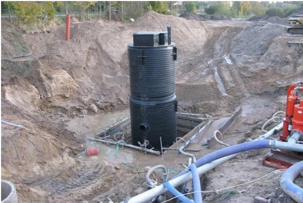
Slika 4.3.4.1. Crpni bazen sa crpnom stanicom u izgradnji
