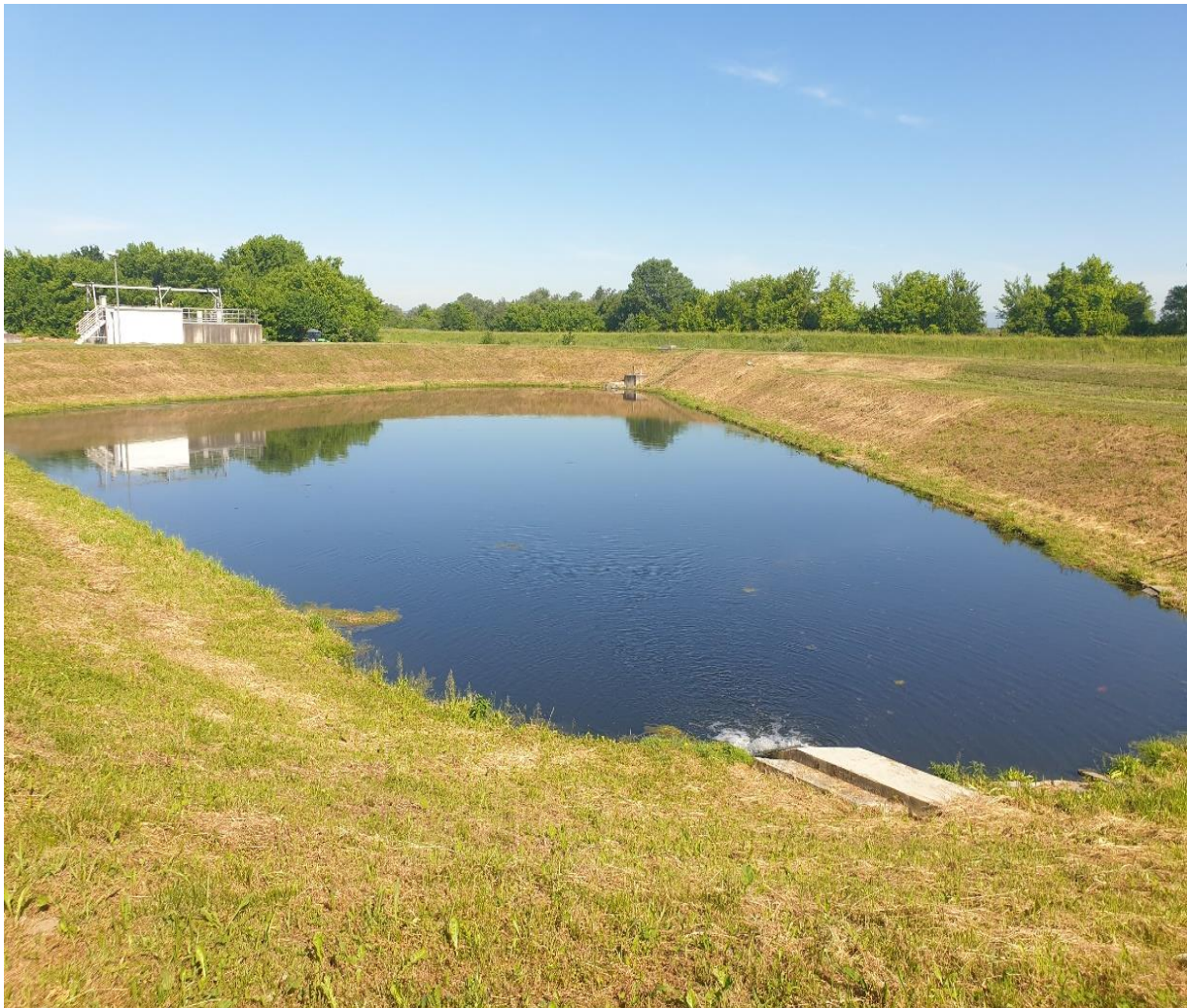
Slika 4.7.2. Prijemnik vode pročišćene na UPOVu
