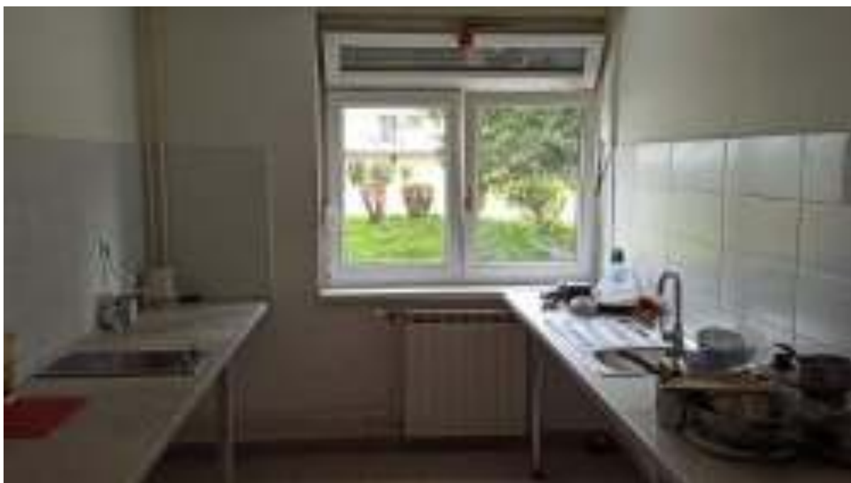
Slika 19 Stanje nakon obnove - čajna kuhinja
