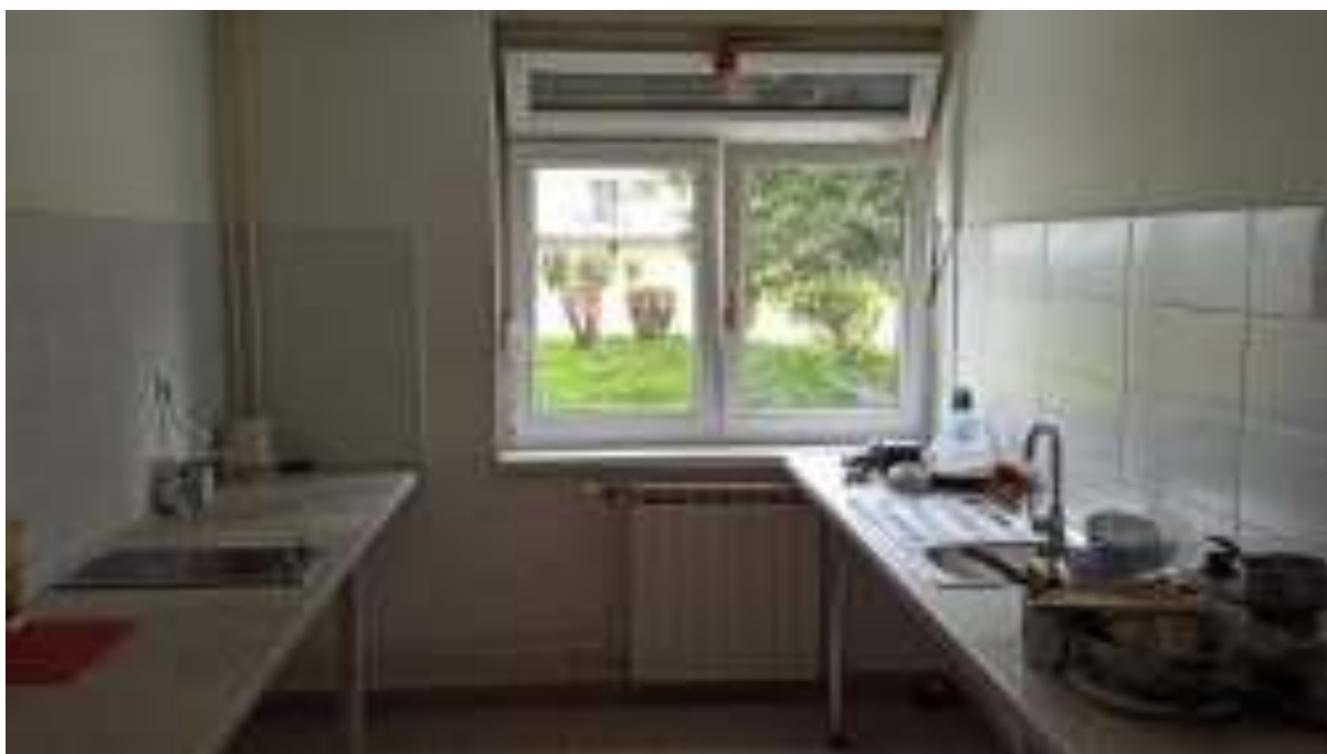
Slika 19 Stanje nakon obnove - čajna kuhinja
