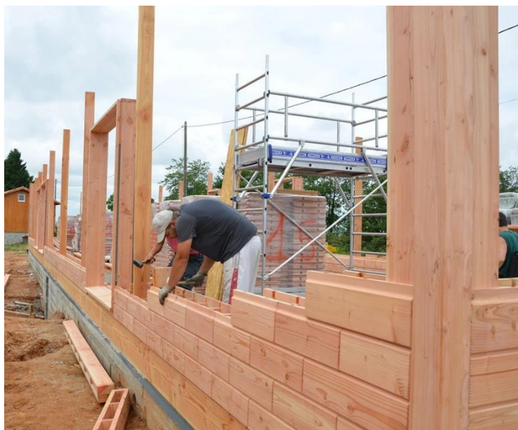
Slika 2.17 Slaganje drvene opeke unutar vertikalala koje čine okvire [33]
