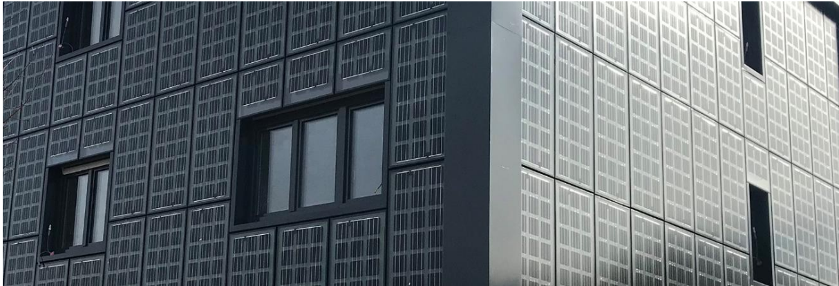
Slika 2.12 ECO Solar modularna kuća [31]
