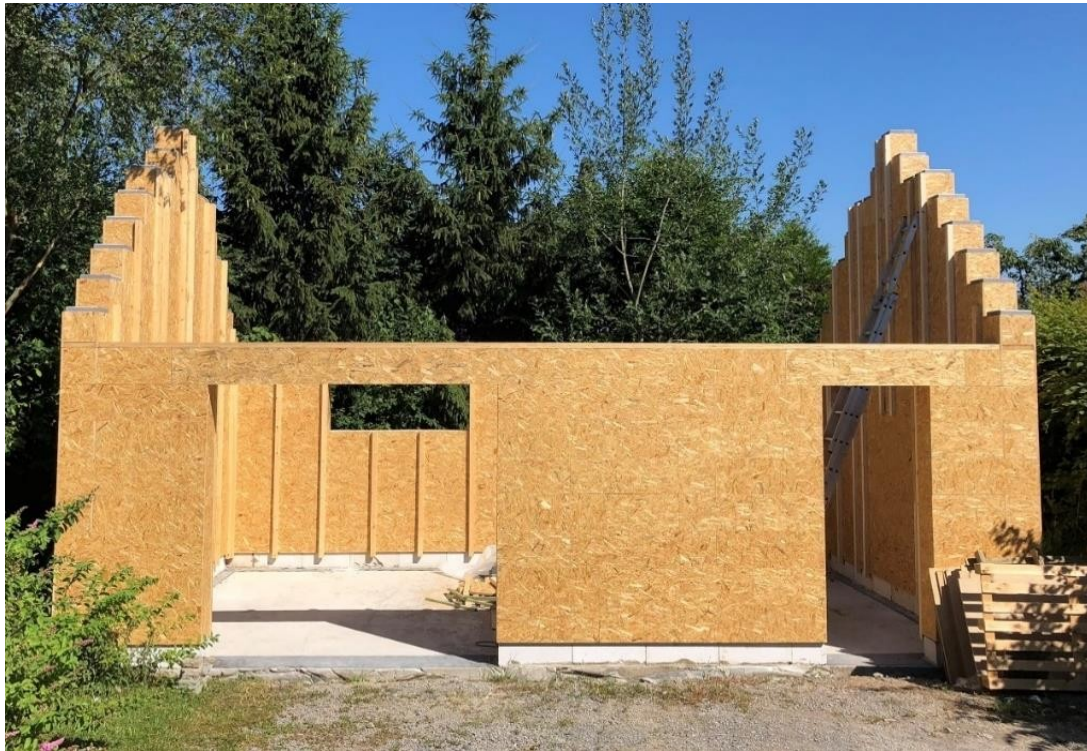
Slika 2.21 Sustav letvi koji stabilizira izolirane blokove
