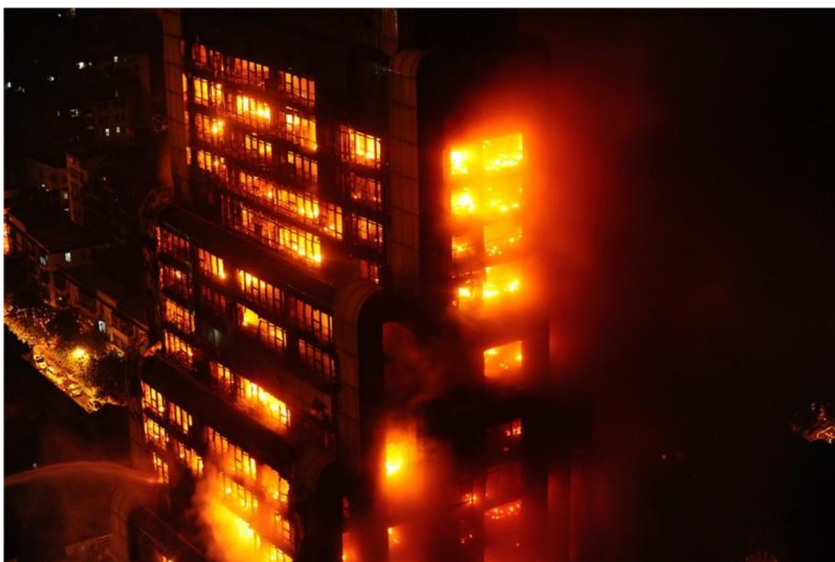
Slika 2.27 Zgrada prilikom požara [36]
