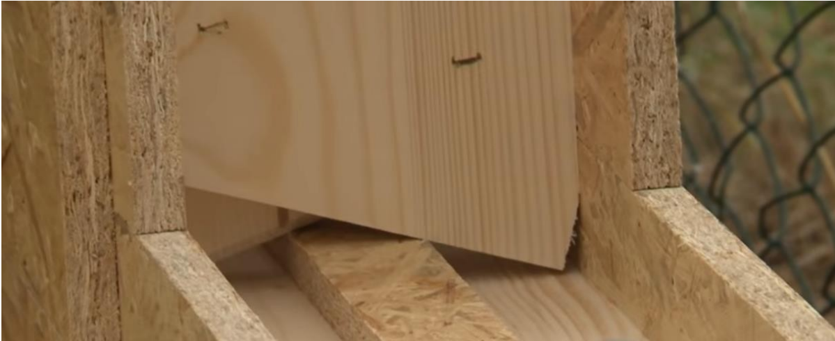
Slika 2.5 Prikaz sustava letvi na temeljnoj ploči za postavljanje prvog reda drvenih blokova
