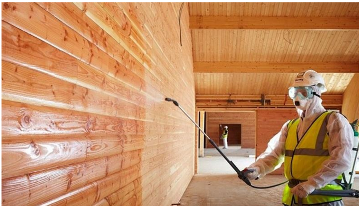
Slika 2.46 Primjena usporivača požara [47]
