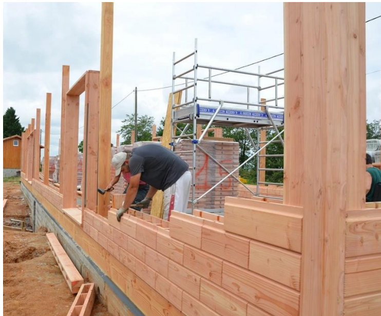
Slika 2.17 Slaganje drvene opeke unutar vertikalna koje čine okvire [33]
