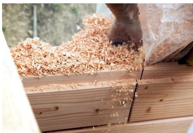
Slika 2.18 Drvene strugotine kao toplinska izolacija
