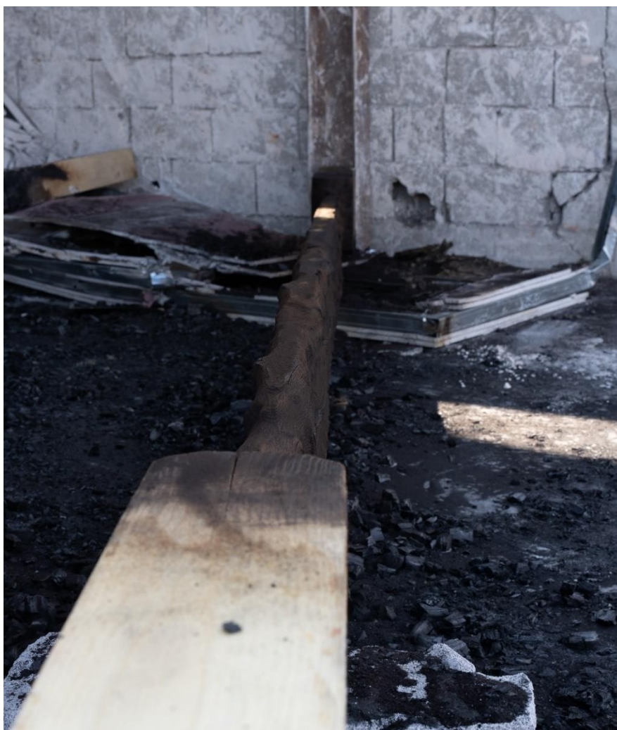
Slika 4.53 Normalna greda nakon čišćenja pougljenog sloja
