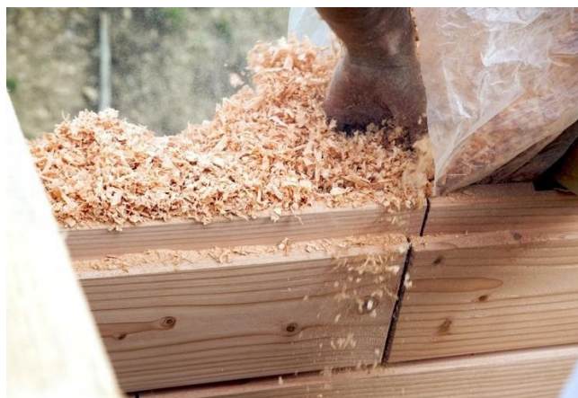
Slika 2.18 Drvene strugotine kao toplinska izolacija
