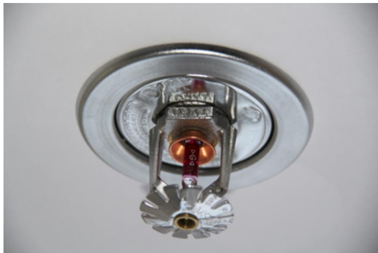
Slika 3.6. Sprinkler mlaznica [18]
