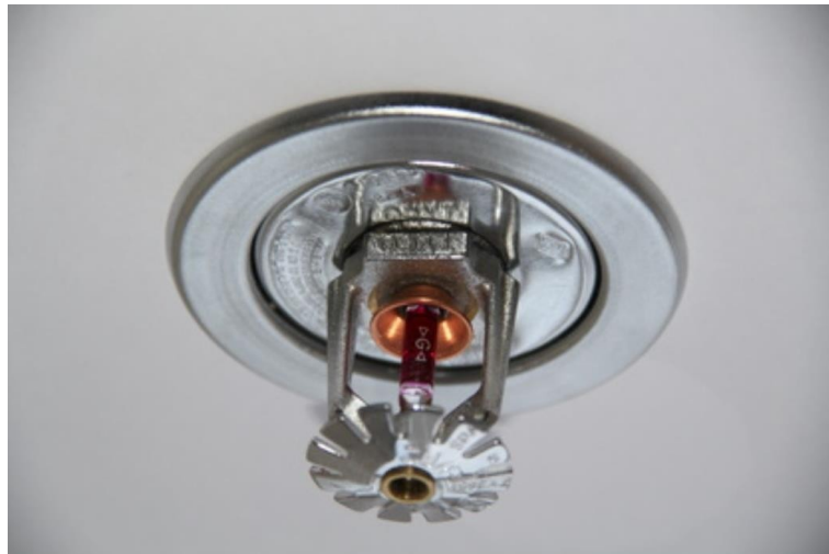
Slika 3.6. Sprinkler mlaznica [18]
