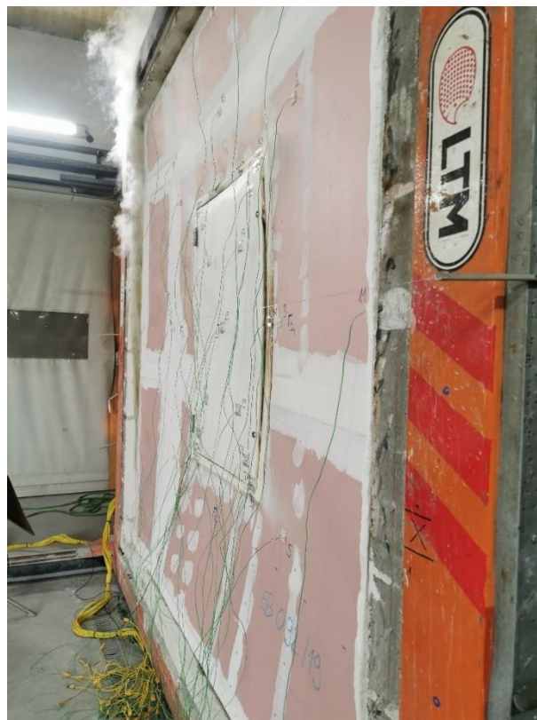
Slika 27. Deformacije požarnih revizijskih vrata
