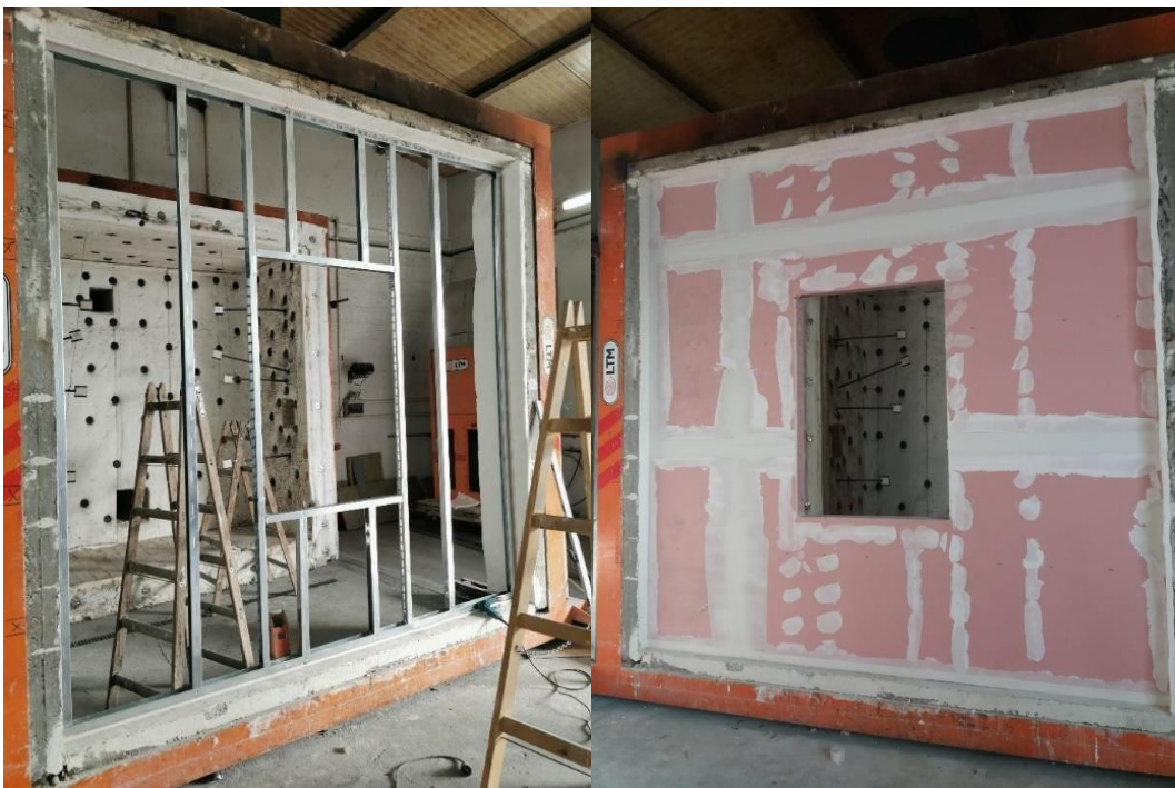
Slika 20. Ugradnja protupožarne pregrade
